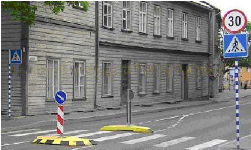
Fußgängerüberweg/Fußgängersicherung mit LÜFT Recycling-Inseln in Tartu (Hauptstadt Südestland) aus dem Praxiskonzept Verkehrinsel
