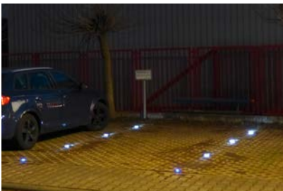
Markierungsnägel im Einsatz
