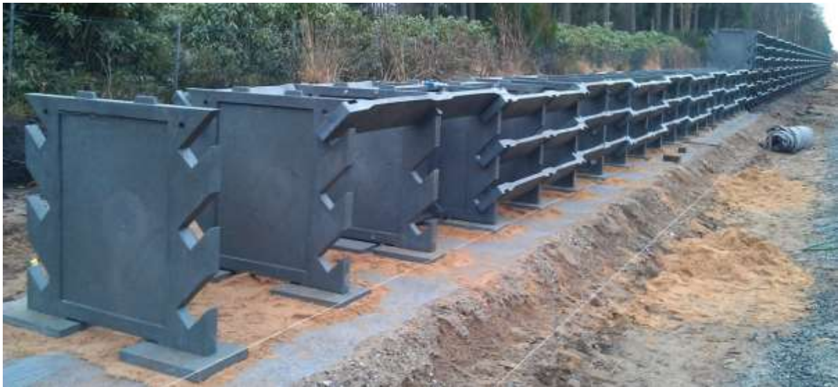
Abb.9: Aufstellen und Ausrichten der Wandscheiben
