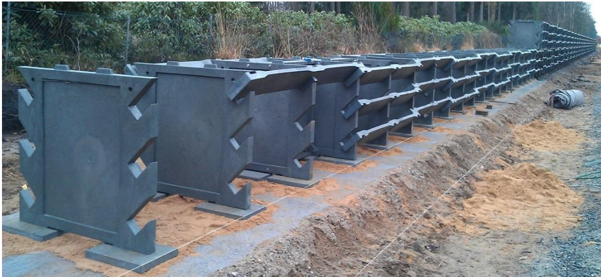
Abb.9: Aufstellen und Ausrichten der Wandscheiben
