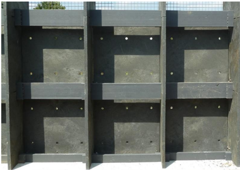
Abbildung 16 Dämmplatten zwischen Wandscheiben und übereinander montiert
