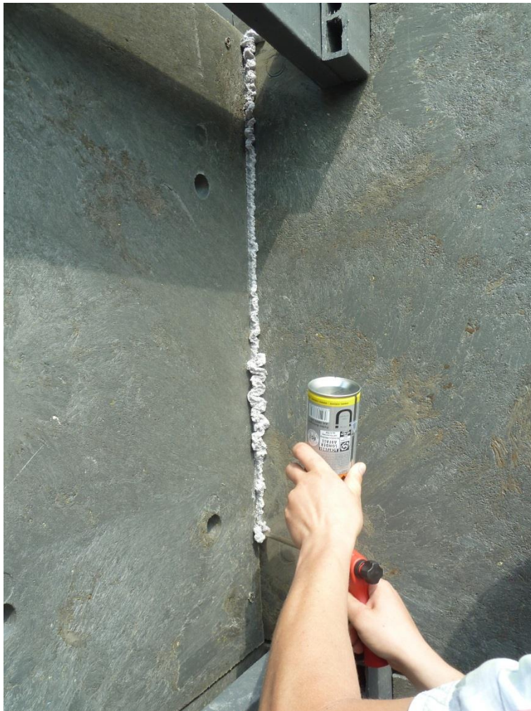
Abbildung 18 Ausschäumen der vertikalen Fugen zwischen Dämmplatte und Wandscheibe
