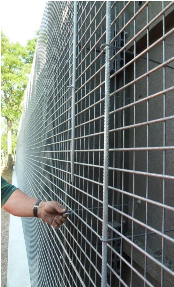
Abbildung 22 Ankerstangen von oben durch die Zughakenösen schieben
