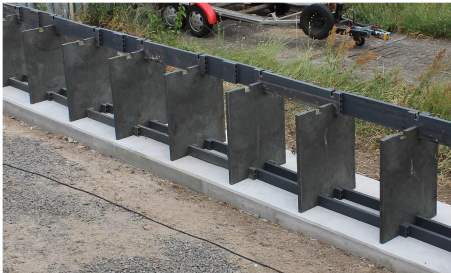
Abbildung 5 Aufstellen und Ausrichten der Wandscheiben im 1. Bauhöhenmeter
