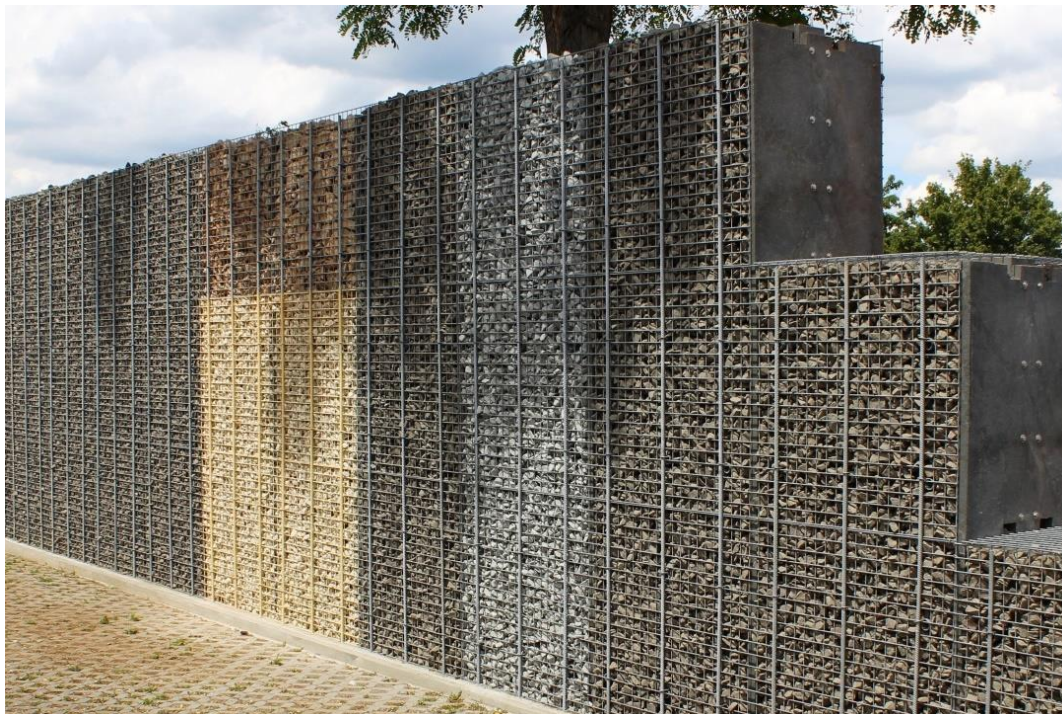
Abbildung 24 Lüft Stonewall mit unterschiedlicher Schotterfüllung
