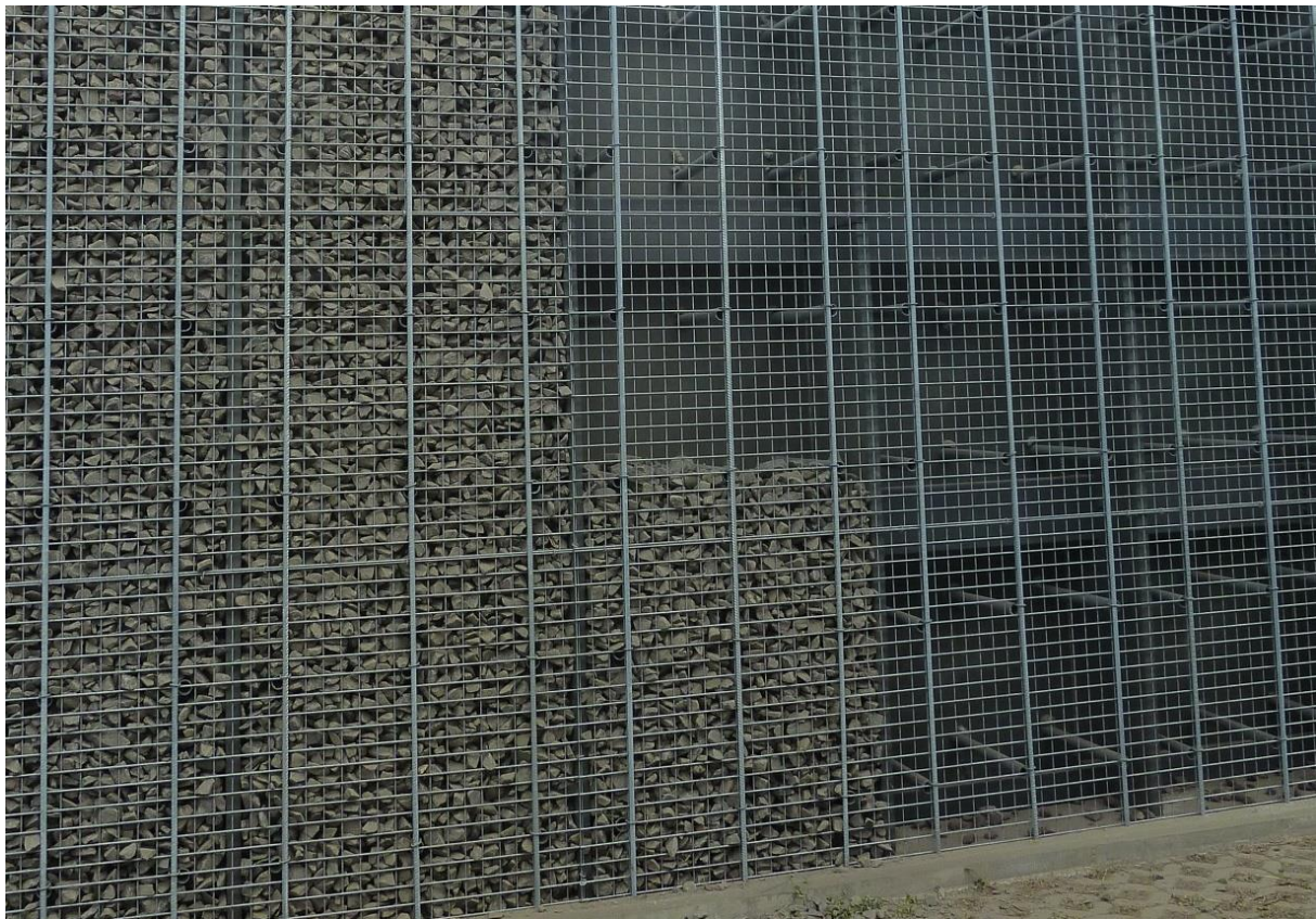
Abbildung 1 Raumgitterkonstruktion mit Bauelementen aus Kunststoff-Recycling
