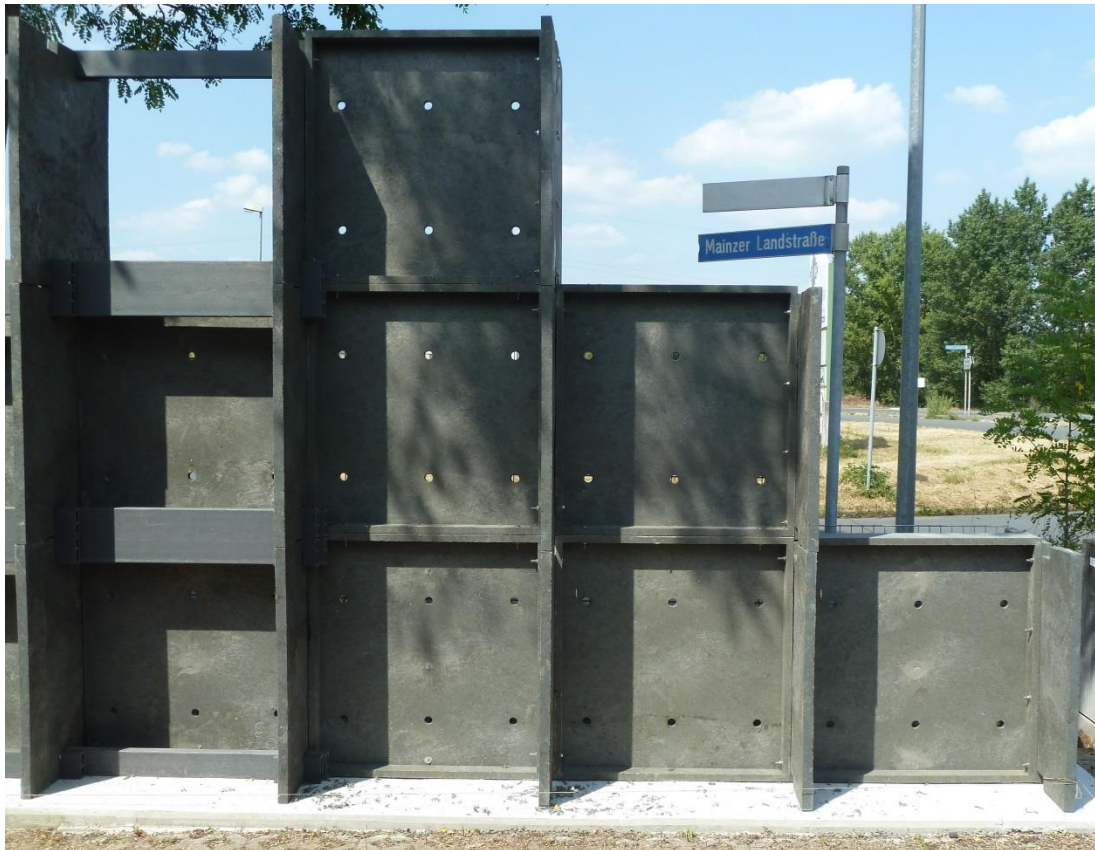
Abbildung 9 Stabilisatoren am Wandanfang mit Abstufungen
