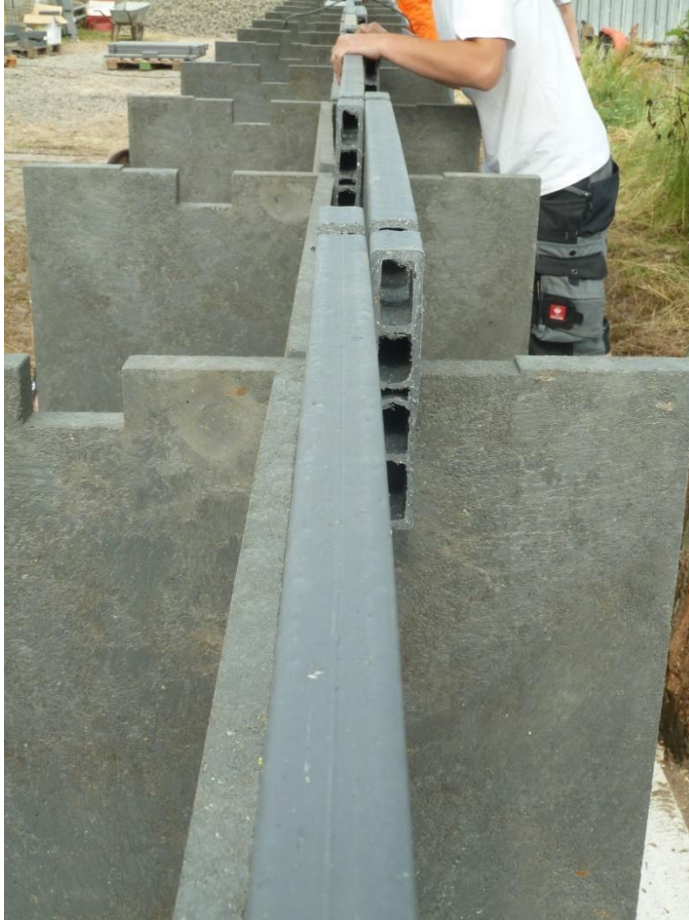
Abbildung 7 Setzbretter in Taschen der Wandscheiben eingebaut
