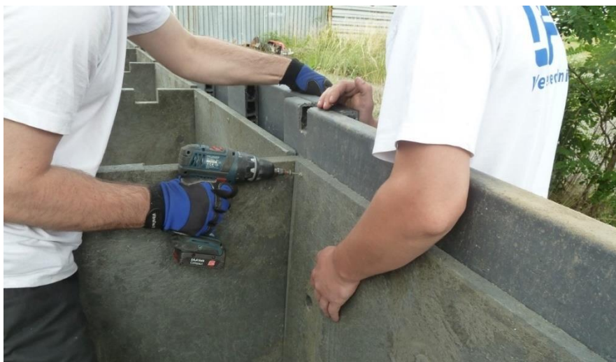
Abbildung 17 Dämmplatte und Setzbrett miteinander verschrauben
