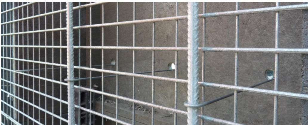
Abbildung 20 Zughaken, Ansicht Absorptionsseite
