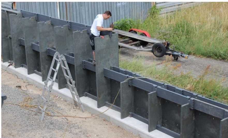
Abbildung 6 Aufstellen und Ausrichten der Wandscheiben im 2. Bauhöhenmeter
