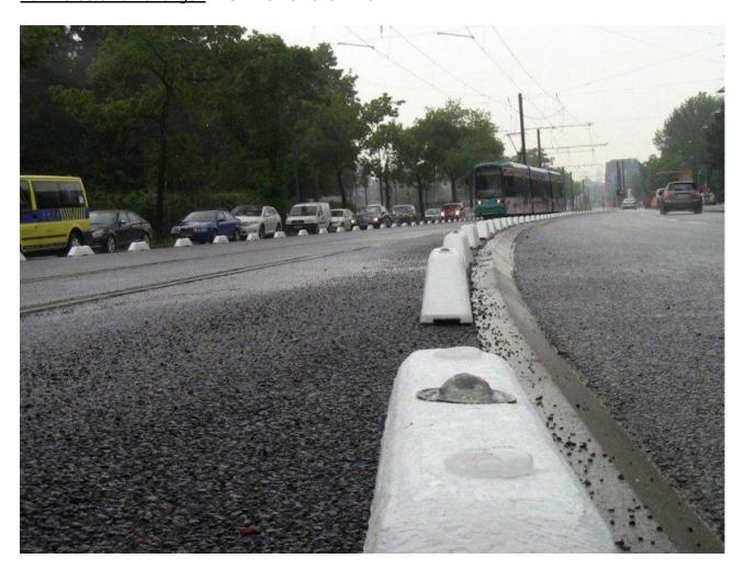
Die massiven Recycling-Elemente sind zur besseren Sichtbarkeit weiß lackiert. Integrierte, selbstreinigende Glas-Kugelreflektoren bringen die gerade hier so wichtige und nötige Sicherheit.
