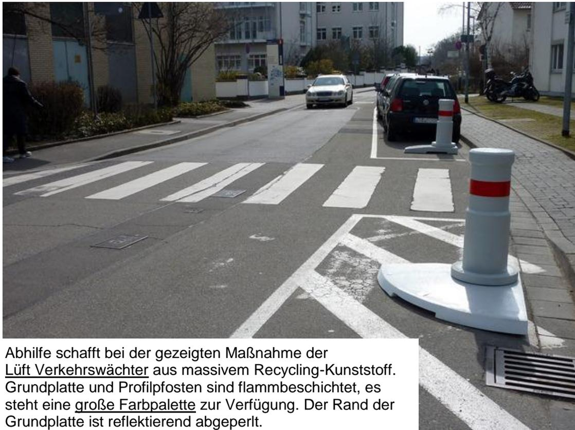
Abhilfe schafft bei der gezeigten Maßnahme der Lüft Verkehrswächter aus massivem Recycling-Kunststoff. Grundplatte und Profilpfosten sind flammbeschichtet, es steht eine große Farbpalette zur Verfügung. Der Rand der Grundplatte ist reflektierend abgeperlt.
