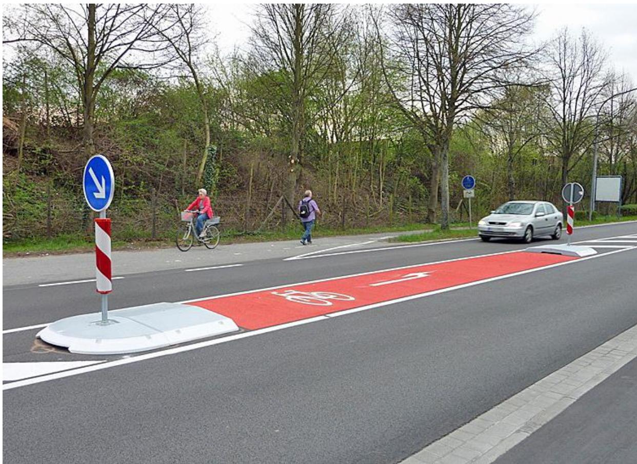
Bei gezeigtem Beispiel wurde die nicht vorhandene Breite einfach durch Länge ausgeglichen. Eingebettet in eine Lüft Verkehrsinsel, 1,60 m breit, jeder Inselkopf aus einem Rund- und einem Rechteckteil bestehend, bietet der sehr langgezogene Mittelbereich genug Platz, um sich mit dem Fahrrad innerhalb der roten Markierung aufzuhalten, bis der Verkehr sicheres Queren zulässt.
