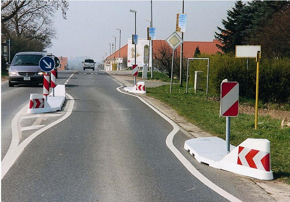
Die Elemente der seitlichen Einengung bestehen aus robustem Kunststoff-Recycling-Material. Die einfache Montage garantiert niedrige Kosten der seitlichen Einengungen.
