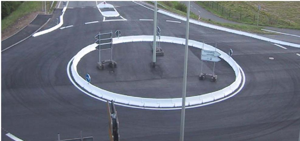
Bild: LÜFT Leitelement im Kreisverkehr;
