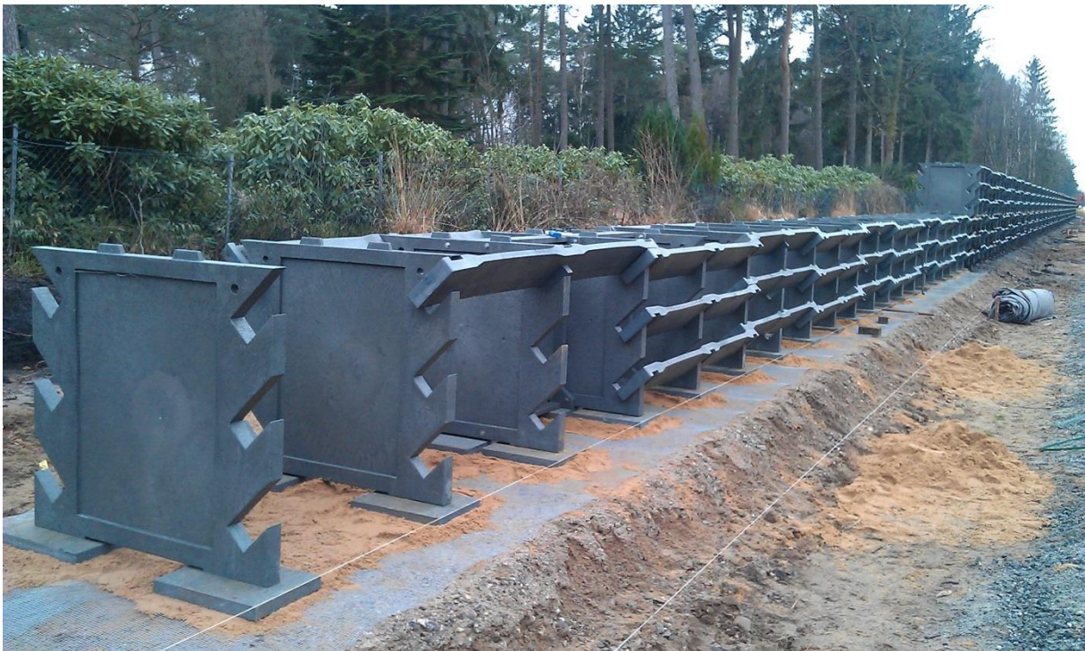
Abb.5: Aufstellen und Ausrichten der Wandscheiben
