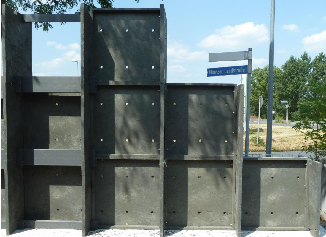
Abbildung 6 Stabilisatoren am Wandanfang mit Abstufungen
