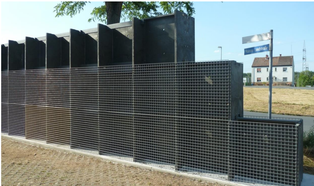
Abbildung 1 Lüft Stonewall Recycling während des Aufbaus
