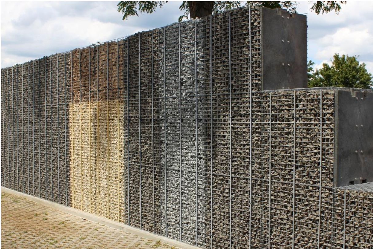
Abbildung 13 Lüft Stonewall mit unterschiedlicher Schotterfüllung
