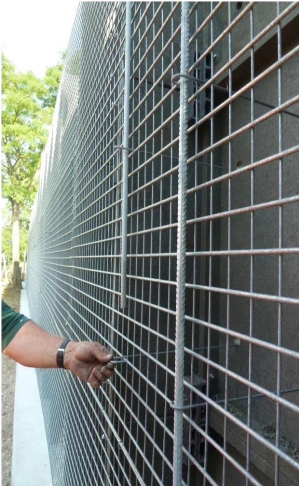
Abbildung 11 Ankerstangen von oben durch die Zughakenösen schieben
