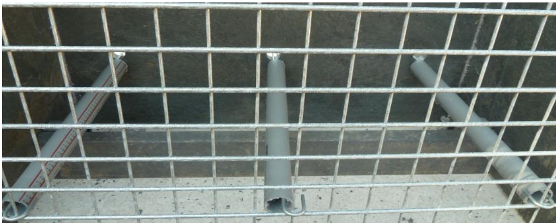
Abbildung 10 Distanzrohr und Zughaken, Ansicht Anliegerseite
