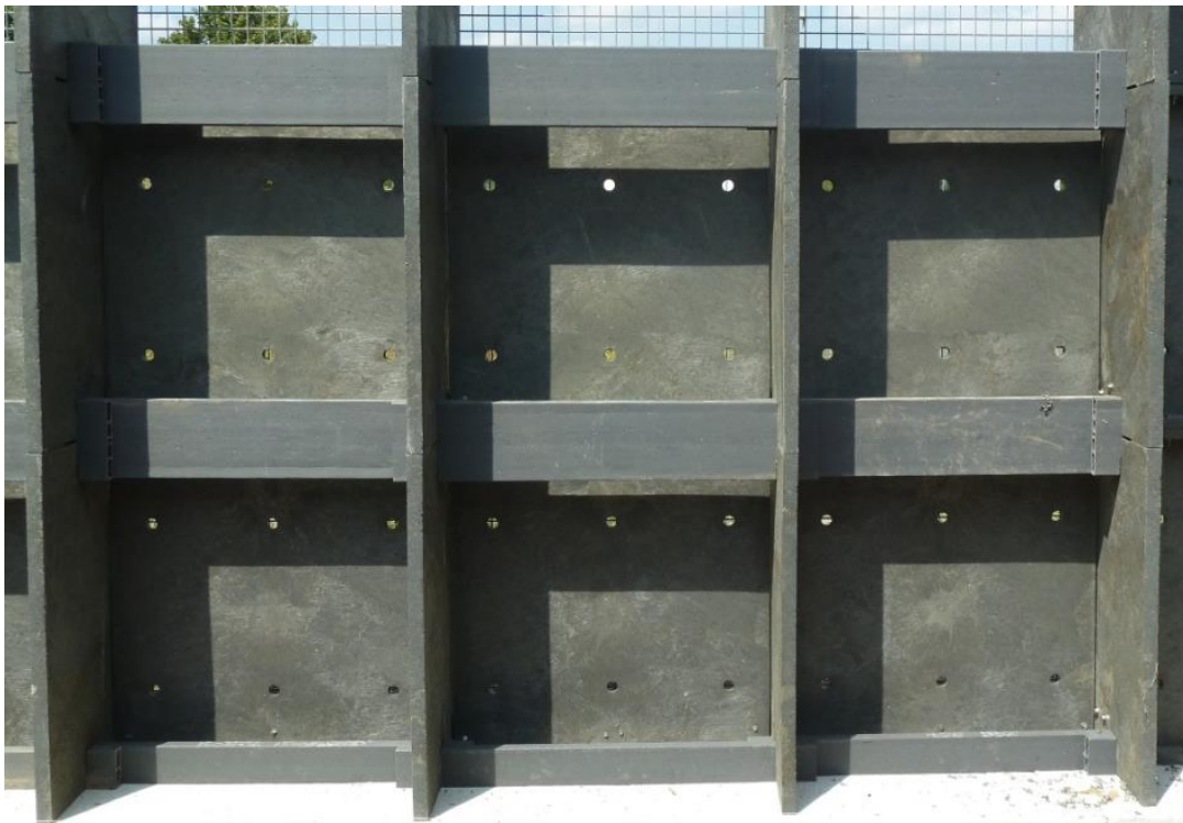
Abbildung 7 Dämmplatten zwischen Wandscheiben und übereinander montiert
