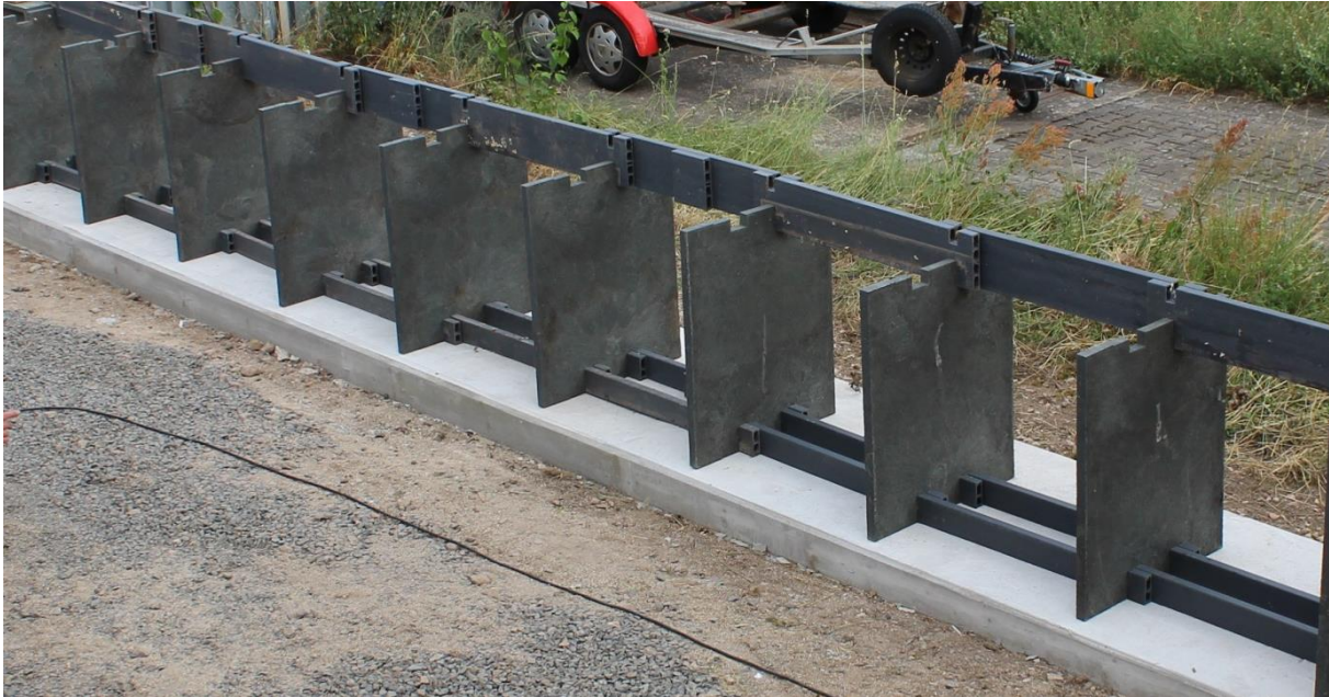
Abbildung 4 Aufstellen und Ausrichten der Wandscheiben im 1. Bauhöhenmeter
