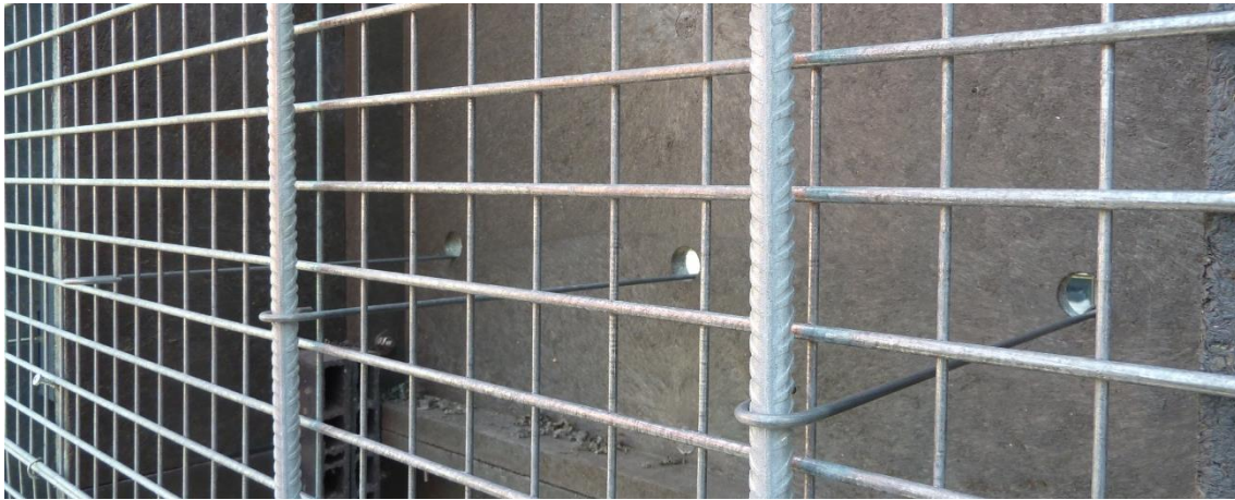
Abbildung 9 Zughaken, Ansicht Absorptionsseite
