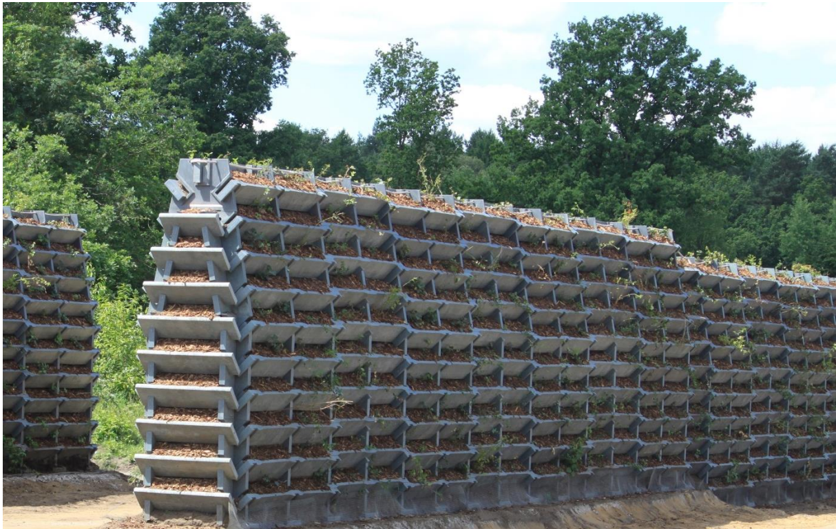
Abb. 3: Bepflanzbares Abschlussfeld LSW Höhe 3,50 m
