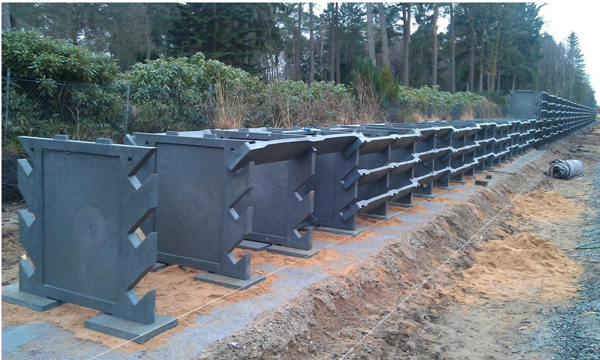
Abb.5: Aufstellen und Ausrichten der Wandscheiben
