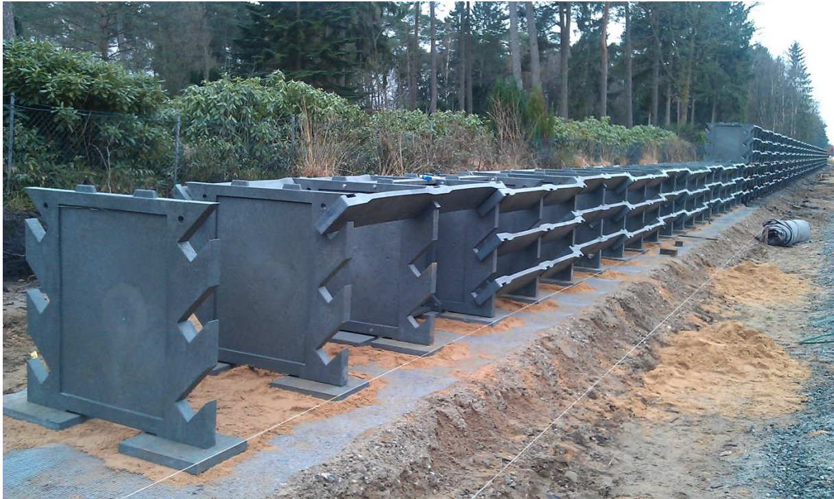
Abb.9: Aufstellen und Ausrichten der Wandscheiben
