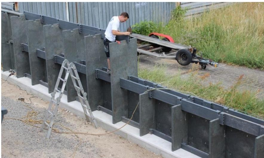
Abbildung 6 Aufstellen und Ausrichten der Wandscheiben im 2. Bauhöhenmeter
