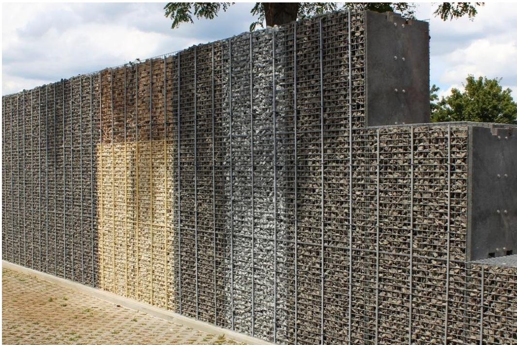
Abbildung 24 Lüft Stonewall mit unterschiedlicher Schotterfüllung
