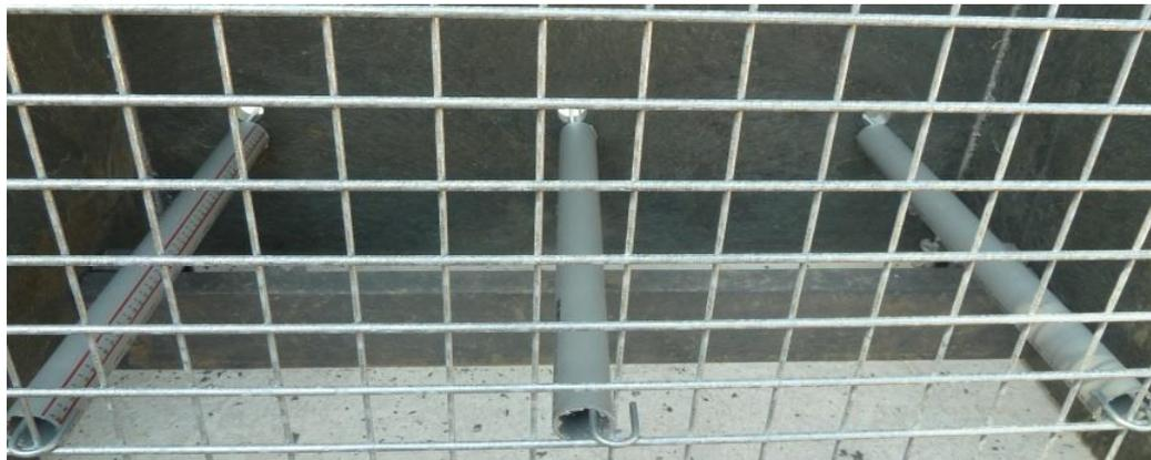
Abbildung 21 Distanzrohr und Zughaken, Ansicht Anliegerseite
