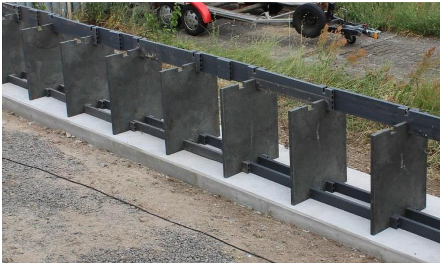
Abbildung 5 Aufstellen und Ausrichten der Wandscheiben im 1. Bauhöhenmeter
