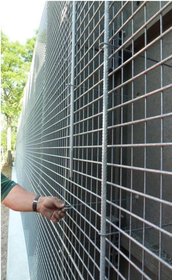
Abbildung 22 Ankerstangen von oben durch die Zughakenösen schieben
