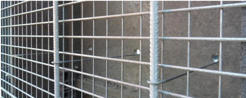
Abbildung 20 Zughaken, Ansicht Absorptionsseite
