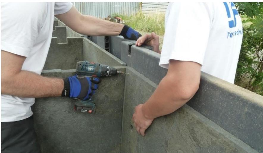
Abbildung 17 Dämmplatte und Setzbrett miteinander verschrauben
