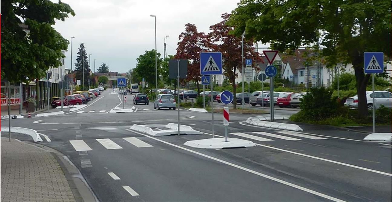
Das hohe Verkehrssicherheitsniveau eines kleinen Kreisverkehrs resultiert aus dem niedrigen Geschwindigkeitsniveau aller Verkehrsteilnehmer. Die vollständige Befahrbarkeit für alle zugelassenen Fahrzeuge bedingt, dass die Kreismittelinsel von Schwerlastverkehr langsam problemlos überfahrbar ist.
