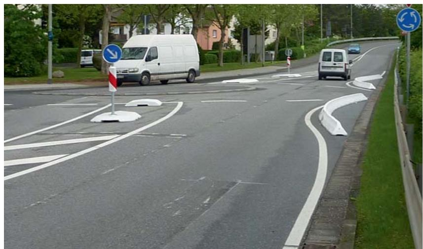
Dieser Kreisverkehr ist nicht so stark frequentiert. Es bedarf keiner Fußgängerquerung, die Recycling-Inseln bilden bei dieser Installation Fahrbahnteiler. Fahrbahnteiler führen den Verkehr, verdeutlichen die Wartepflicht. Mit den mobilen Leitborden wird die Fahrbahn verschwenkt – ohne bauliche Eingriffe in den vorhandenen Straßenbelag.
