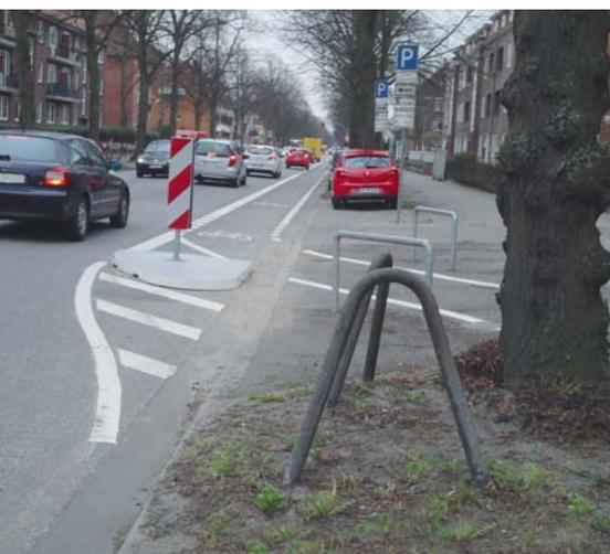
Aber die Überleitungen sind nicht ganz ungefährlich – weder für den Radfahrer noch für den Autofahrer. Um diese neuralgischen Stellen sicher zu gestalten, bieten wir unterschiedlich breite, mobile Inseln an. Die Elemente werden einfach auf die Fahrbahn gelegt, ausgerichtet und verdübelt. Eine Klemmhülse bietet die Möglichkeit der direkten Beschilderung.
