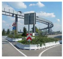
Wenn Farbe im Einheitsgrau gewünscht wird, können mit den flexiblen Pflanzwinkeln aus dem Grünen Konzept von **Lüft** nahezu alle Anforderungen an Geometrie und Abmessung entsprechend der Örtlichkeit erfüllt werden. Die Elemente sind aufgeständert, Änderungen am Fahrbahnbelag sind somit nicht erforderlich.
