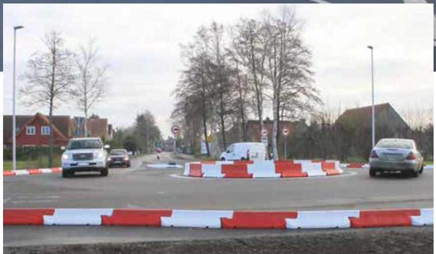
**Die Nachtsichtbarkeit:** Alle eingesetzten **Lüft** Elemente sind reflektierend abgeperlt und mit Glaskugelreflektoren ausgestattet. Die eingebauten Verkehrszeichen sind mit Folie Typ 2 belegt. Zusätzliche Beleuchtung, besonders im Bereich der Querungshilfen, unterstützt die bereits nachtsichtbare Ausstattung der **Lüft** Elemente.
