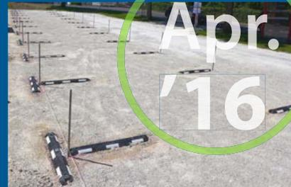
Die Separatoren sind 1000 mm lang, 150 mm breit und haben eine Aufbauhöhe von 50 mm. Die geringe Höhe macht ein Überfahren im Notfall ohne weiteres möglich. Die Schwellen bestehen aus Recycling-Gummi und sind nachtsichtbar mit weißen Reflexstreifen ausgestattet.
