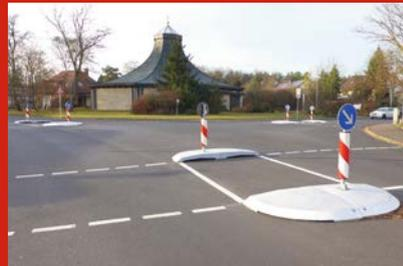
Drei Querungshilfen 2,50 m breit bieten jetzt den notwendigen Schutz und die Möglichkeit zum sicheren Queren. Die massiven Inselköpfe aus Recycling-Kunststoff strukturieren die Fahrbahn; durch die Fahrstreifenverengung wird gleichzeitig die Geschwindigkeit reduziert. Vor Allem ist der Kreuzungsbereich jetzt wesentlich übersichtlicher und dadurch sicher.
