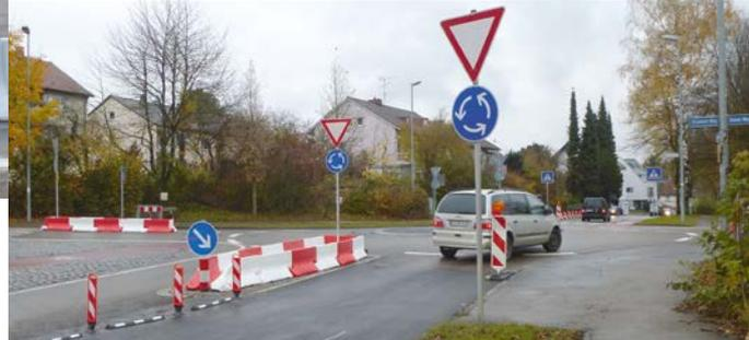
In Biberach an der Riss hat Lüft zur Unterstützung der Verkehrssicherheit bei einem bereits installierten Minikreis bestehende Fahrbahnteiler mit den Lüft Leitelementen erhöht, um damit mehr Akzeptanz bei den Verkehrsteilnehmern einzufordern. Vorgelagerte Rampen haben wir mit Leitschwellen Separator und flexiblen Warnbaken hervorgehoben. Übrigens, beides bewährte Produkte aus dem Lüft-Shop Sortiment: [www.lueft-shop.de](http://www.lueft-shop.de).
