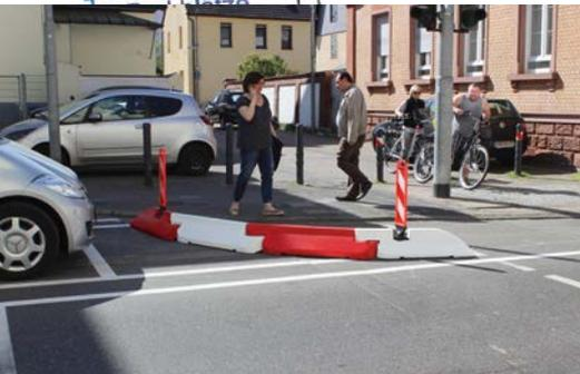
Lüft Leitborde bilden den Fahrbahnrand. Es handelt sich um ein reines Stecksystem, das Bord ist im Fuß und im Konus rund ausgebildet. Über das Stecksystem haben die massiven Leitborde eine standfeste Verbindung. Sie können gegen Verschieben bei seitlichem Anfahren konstruktiv im Fuß mit einer entsprechenden Bodenverankerung zusätzlich gesichert werden.
