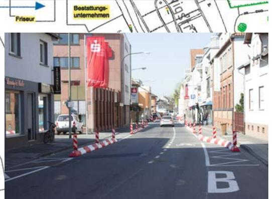
Wenn über längere Teilstücke nicht geparkt werden soll, bildet das Leitbord den rechten und linken Fahrbahnrand. An neuralgischen Stellen wie Eingängen oder Querungsmöglichkeiten kann die Kette unterbrochen werden. Mit entsprechenden Anfangs- und Endbor-den bleibt das System homogen.
