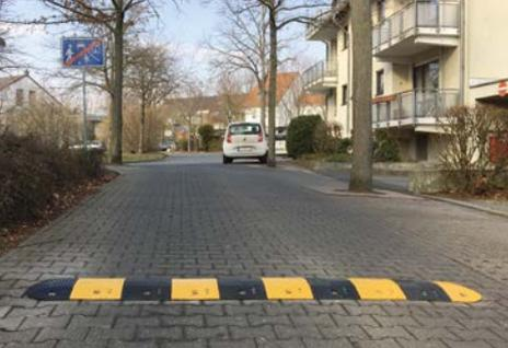
Fahrbahnschwellen bestehen aus Anfangs-, End- und beliebig vielen Mittelteilen, deren Anzahl sich nach der Fahrbahnbreite richtet. Verschraubt und bei Bedarf zusätzlich verklebt bieten die Fahrbahnschwellen dauerhafte Temporeduzierung. Die auffällige schwarz-gelbe Farbgebung bringt die nötige
