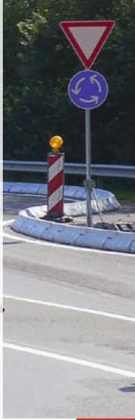
**Leitelement** und **Leitbord** kommen überall dort zum Einsatz, wo **Flexibilität** gefordert ist. Fuß und Konus der Elemente sind rund ausgebildet, so dass neben Geraden auch Verschwenkungen und Radien mühelos gebaut werden können. Anfang- und Endelemente komplettieren die Produktreihe. Für beide Ausführungen bietet Lüft das jeweils passende Beschilderungssystem.
