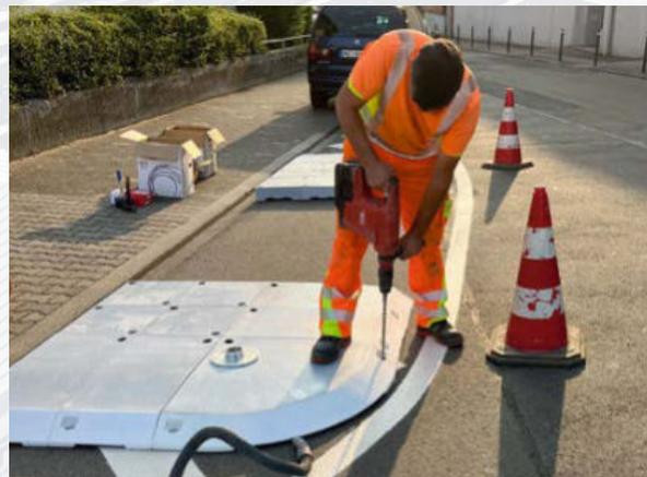
Die Montage ist ab sofort noch einfacher, dank leichter Module. Alle Inselemente sind per Hand zu montieren, Verhebevorrichtungen und schweres Gerät gehören der Vergangenheit an.
