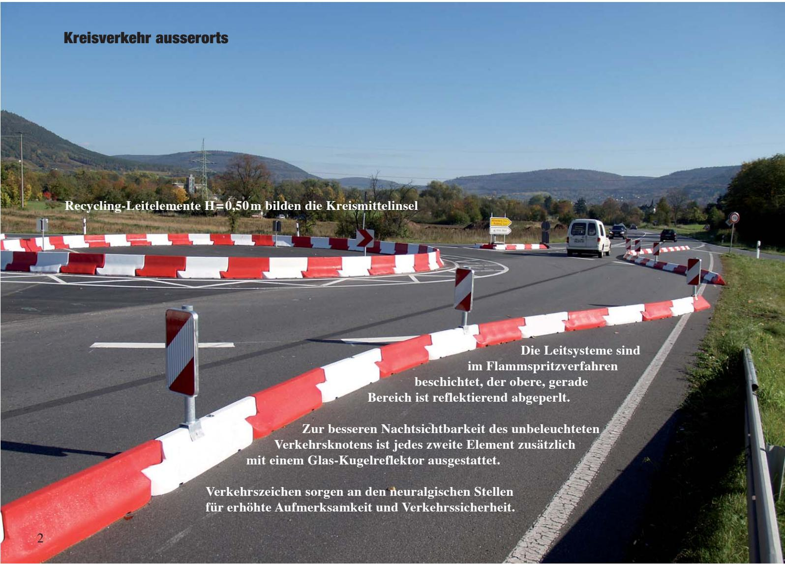
Recycling-Leitelemente  $H=0,50\text{m}$  bilden die Kreismittelinsel
