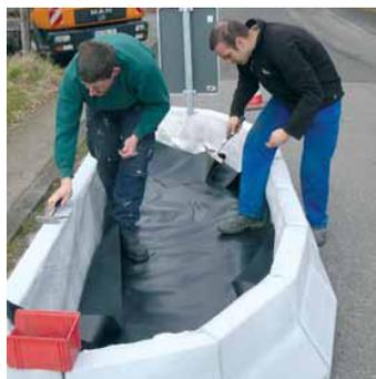
Wurzelschutzfolie und Vlies gemäß Systemvorschlag einbauen.
