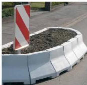
Verfüllmaterial unbedingt zeitnah einbringen, da das System Pflanzinsel seine Standfestigkeit durch die Erdlast erhält.
