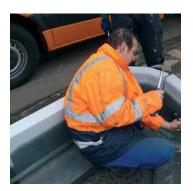
Stahl-Rispenband konstruktiv im unteren Drittel der Pflanzwinkel befestigen.
