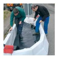
Wurzelschutzfolie und Vlies gemäß Systemvorschlag einbauen.
