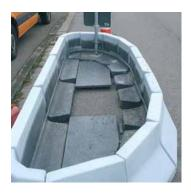
Pflanzwinkel entsprechend der Inselgeometrie aufstellen und ausrichten. Bodenplatten anpassen und einlegen.
