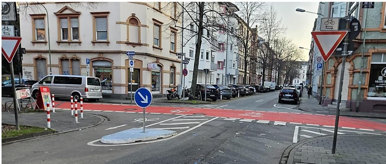
Verschwenkungs- und Beruhigungsinseln aus Recycling-Kunststoff verengen die Fahrbahn und sorgen dafür, dass Autos langsamer fahren. Gleichzeitig verbessern sie die Sicht auf den Radverkehr spürbar. Radfahrende werden früher wahrgenommen und können die Kreuzung sicher passieren. So wird ein bekannter Gefahrenpunkt entschärft und der Vorrang des Radverkehrs klarer sichtbar.
