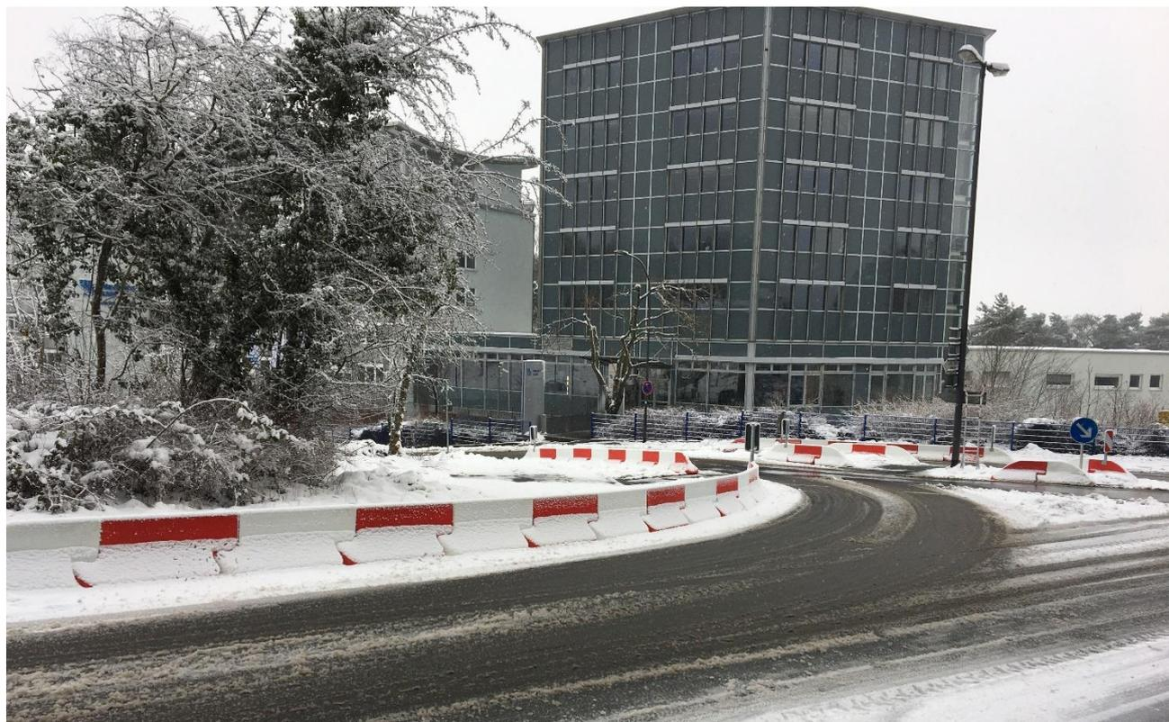
Die verantwortlichen Verkehrsfachleute haben sich für mehr Sicherheit der Fußgänger an einer stark frequentierten Kreuzung für die 0,50 m hohen, massiven [Lüft Leitelemente](#) entschieden.
