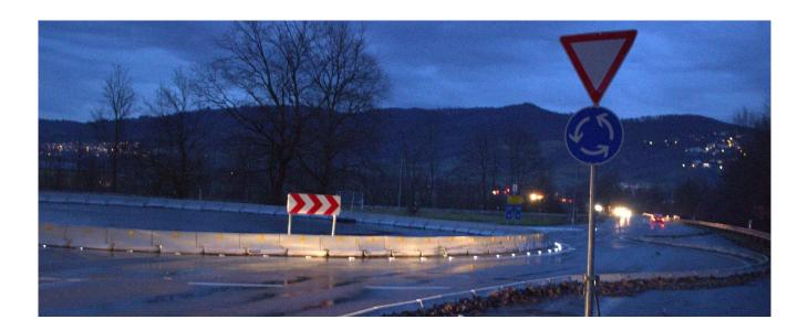
Abhilfe schaffen ab sofort die LED Markierungsnägel aus dem Lüft LED Signalsysteme Programm. Durch den Markierungsnagel und dessen Überhöhung soll der Verkehrsteilnehmer frühzeitig merken, dass er zu nahe an der Kreismittelinsel unterwegs ist; bei Dämmerung und nachts strahlen die LED unübersehbar und autark.
