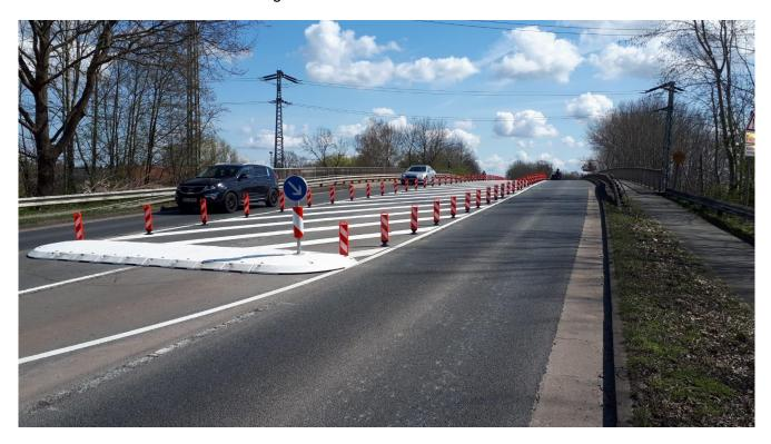
Das Brückenbauwerk, wie vielerorts etwas in die Jahre gekommen, muss traglastreduziert werden. Der Neubau der Brücke ist in Planung, aber bis zur Umsetzung muss aus Sicherheitsgründen eine kurzfristige Lösung her.
