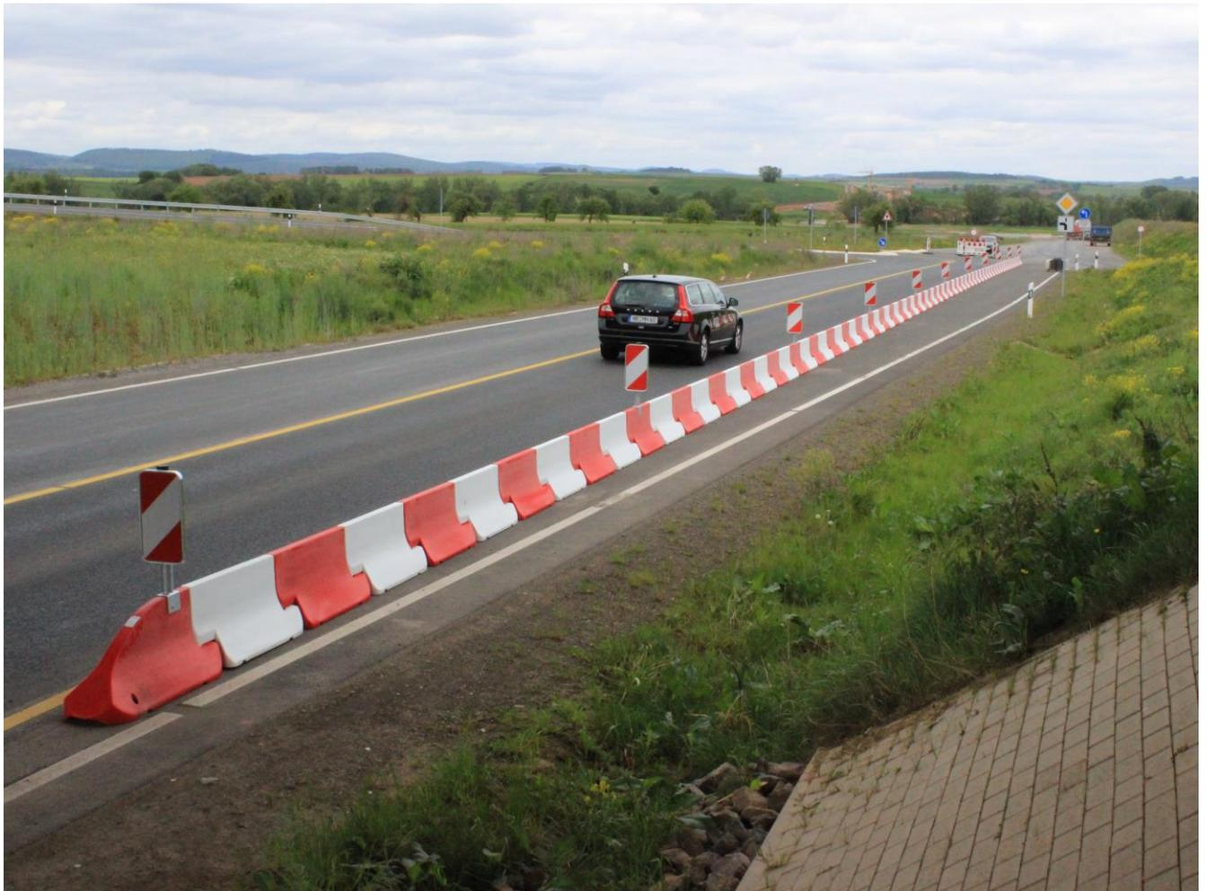
Um die Geschwindigkeit nachhaltig zu reduzieren, wurde die Bestandsfahrbahn über die massiven Leitelemente aus dem Lüft Modulkonzept merklich eingeengt.
