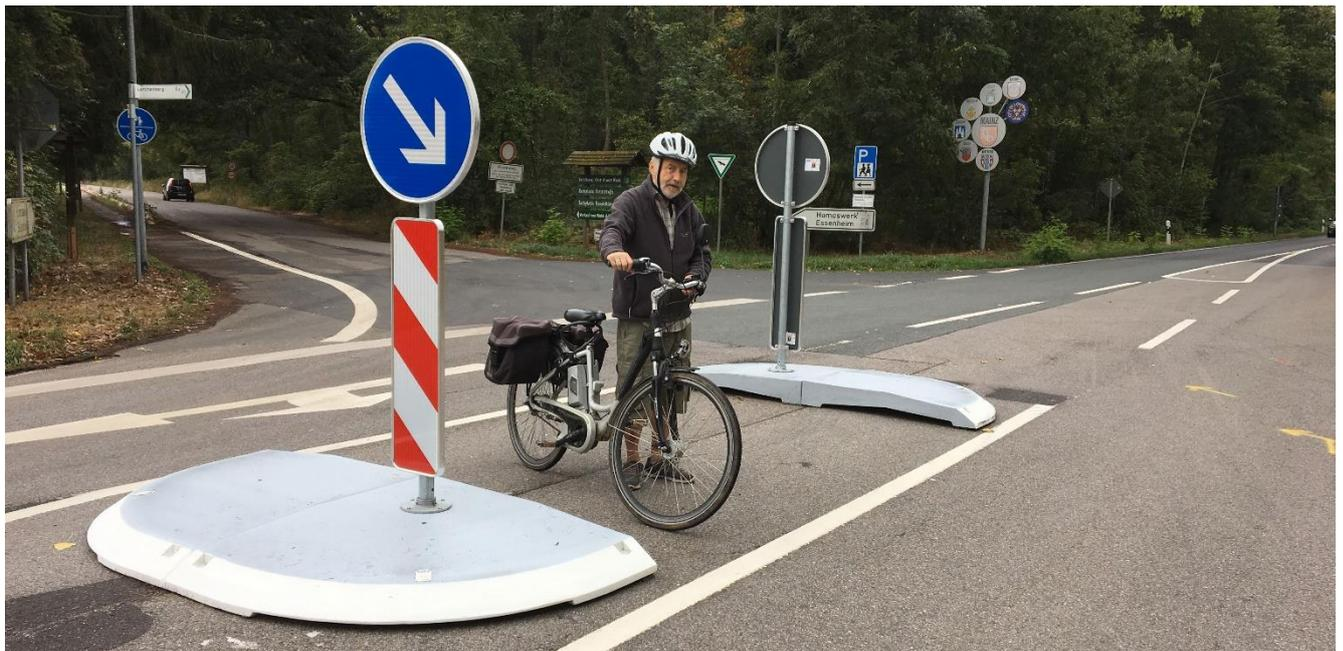
Einfach aufgelegt, mit drei Bodenverankerungen pro Inselelement fixiert und über die Klemmhülse beschildert können die Elemente aus massivem Kunststoff Recycling binnen kurzer Zeit installiert werden. Die Auflage findet auch bei dieser Insel nur am Rand statt, so dass Fahrbahnunebenheiten größtenteils aufgefangen werden.
