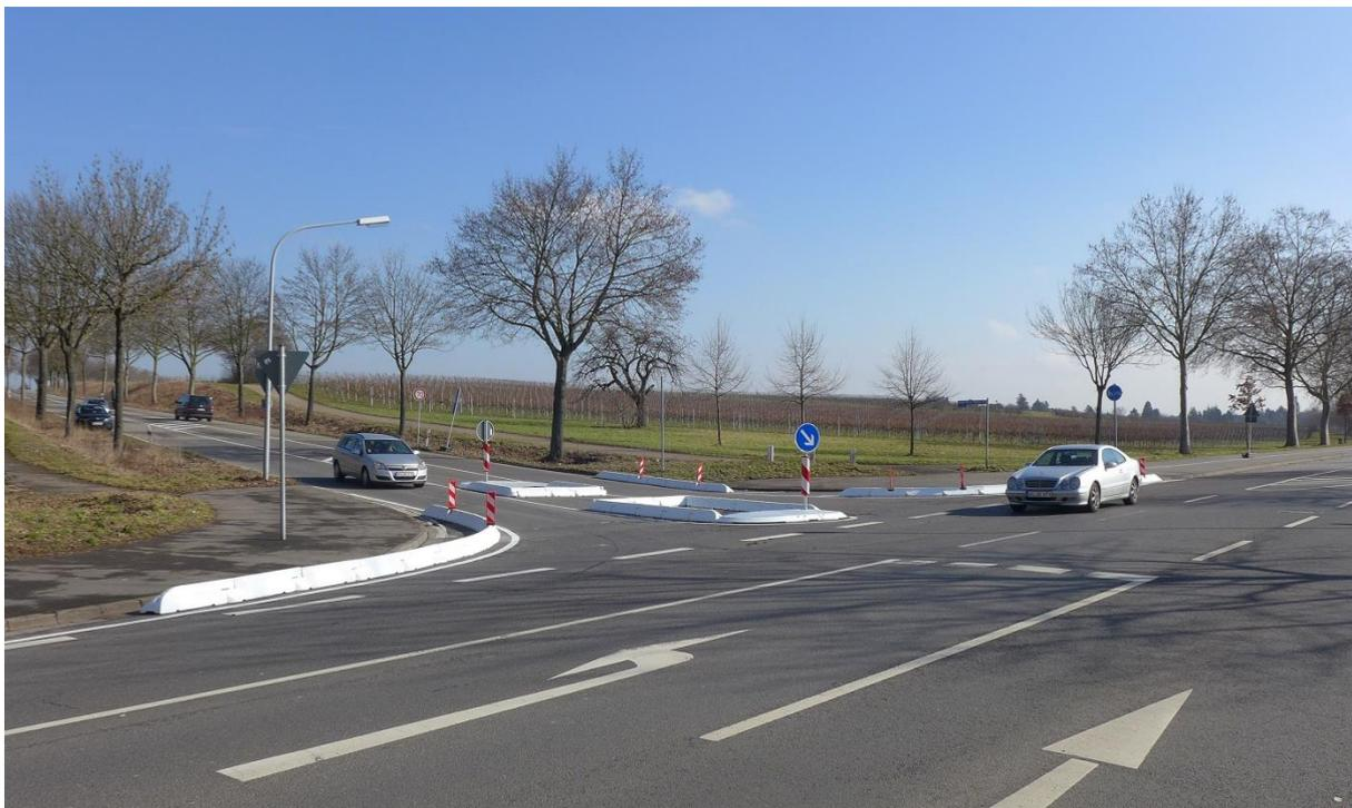
Die Radfahrer-Querungshilfe ist mit jeweils einem Inselkopf in der Breite 3,00 m gebaut. Der Inselkopf besteht aus Elementen der Lüft Flexinsel, die man durch Modulbauweise ab 2,50 m im 50er Raster den Bedürfnissen der jeweiligen Situation anpassen kann. Verlängert wurde sie mit massiven Leitborden, die auch für die seitlichen Einengungen zum Einsatz kamen.
