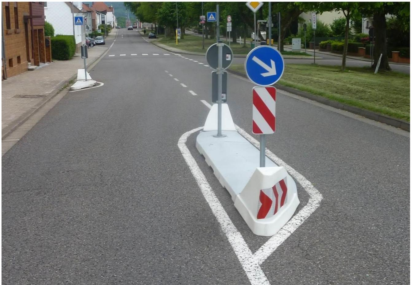
Das [Modulkonzept](#) aus dem Recycling Produktportfolio von Lüft besteht aus drei geometrisch unterschiedlichen Inselementen:
