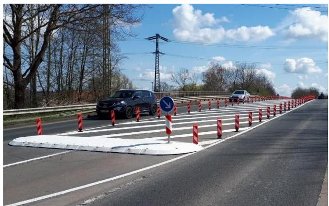
Die massiven [Lüft Leitsysteme](#) aus recyceltem Kunststoff sind geradezu prädestiniert, den Verkehr auf Brücken durch einseitige oder auch doppelseitige Einengungen einfach und nachhaltig einzuschränken, um damit die Traglast zu reduzieren.
