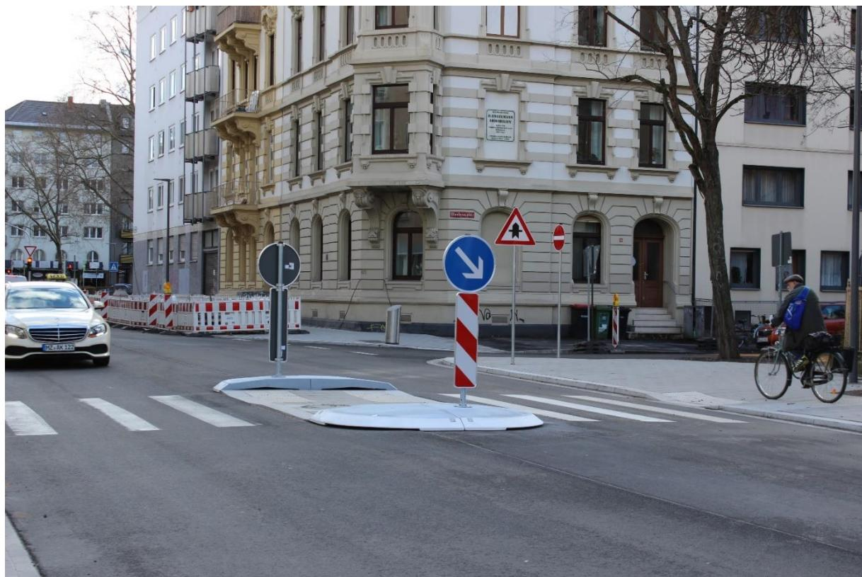
Im Zuge der Straßensanierung wird mit den Formteilen aus dem Hause Lüft zur Finalisierung der Maßnahme blitzschnell eine Querungshilfe montiert. Dadurch kann die Sperrung aufgehoben und die Straße rechtzeitig wieder für den Verkehr freigegeben werden, wenn auch noch ein paar Restarbeiten zu erledigen sind.
