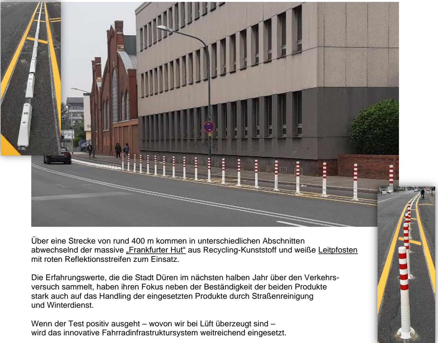
Über eine Strecke von rund 400 m kommen in unterschiedlichen Abschnitten abwechselnd der massive „Frankfurter Hut“ aus Recycling-Kunststoff und weiße Leitpfosten mit roten Reflektionsstreifen zum Einsatz.
