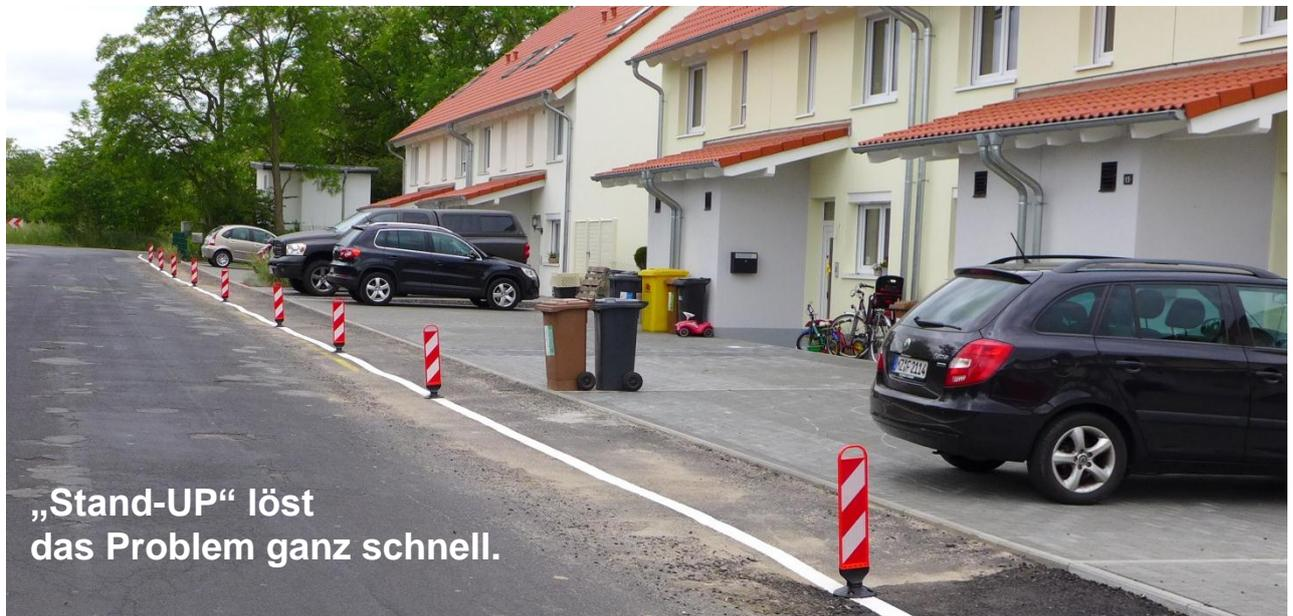
Die flexible Leitbake „Stand-Up“, ausgestattet mit richtungsweisender Signalfolie RA 2, einfach zu montieren durch den passenden Systemfuß, grenzt den provisorischen Gehweg jetzt deutlich und verkehrssicher ab.
