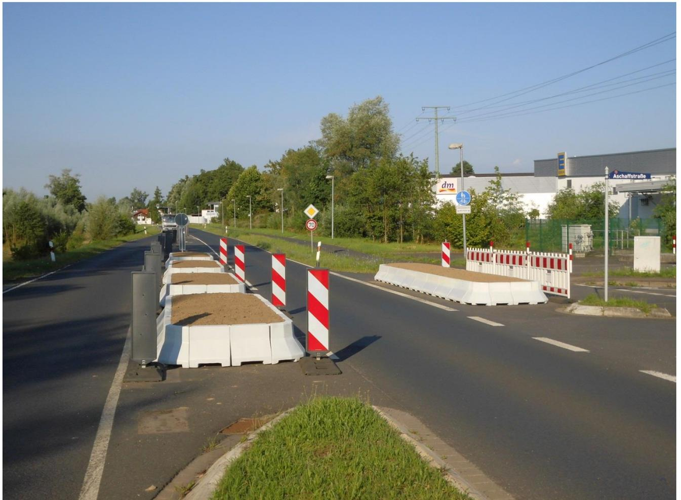
Mit vier Pflanzwinkeln in unterschiedlicher Geometrie, kombiniert mit Bodenplatten lassen sich alle Arten von Fahrbahnteilern und Verkehrsinseln herstellen.
