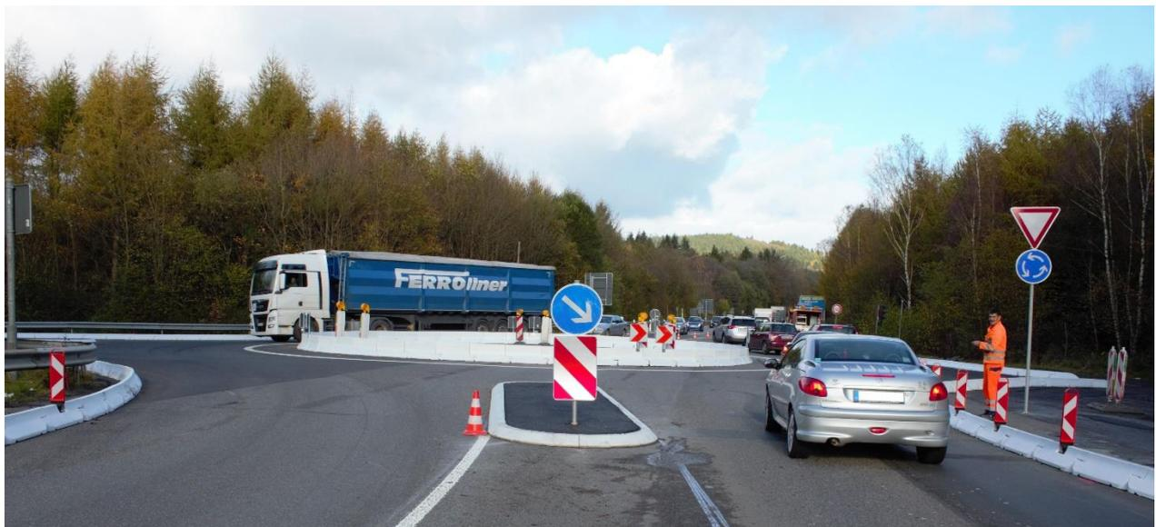
Nach Abschluss der Vorarbeiten wurde an nur einem Tag das komplette Kreisverkehrsprovisorium einschließlich Beschilderung und Markierung hergestellt und um 14:00 Uhr planmäßig für den Verkehr freigegeben.
